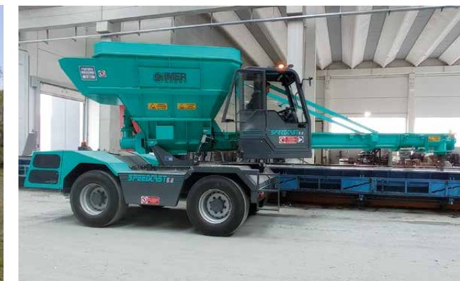
Fase di getto in casseri orizzontali con calcestruzzo SCC
